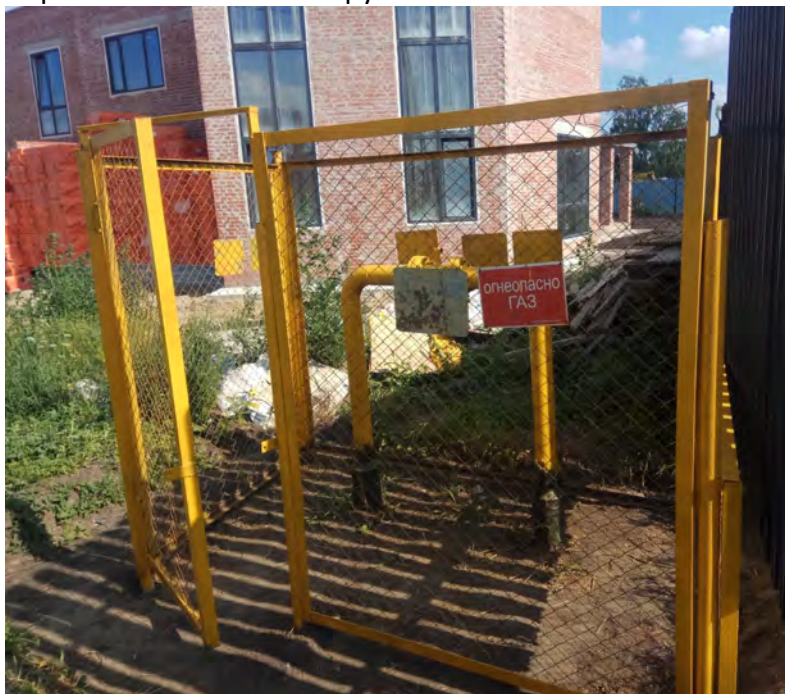
Новое ограждение задвижки на ул. Утренней
